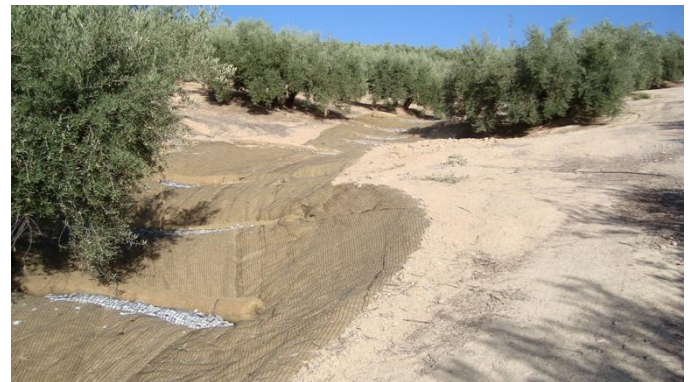
Figura 4. Ejemplos de cubierta vegetal espontánea y mantas orgánicas con biorrollos y gaviones
